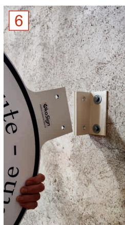
4 - Fixation de la platine avec la visserie fournie (4 vis tirefond + 4 rondelles). Utiliser une clé de 12.
